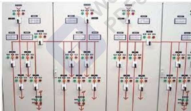
Figura 5-2 Alimentadores radiales de distribución.
