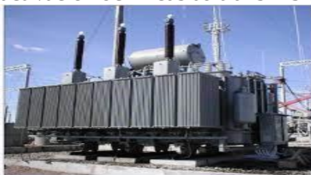
Figura 4-43 Reactor de derivación
