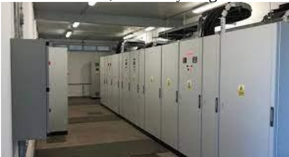
Figura 4-46 Edificio de control.
