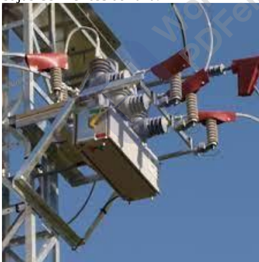
Figura 4-31 Reconector moderno.
