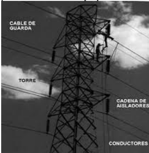
Figura 3-1 Línea de transmisión.
