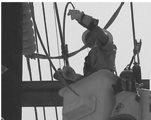
Figura 10-11 Mantenimiento de Distribución.
