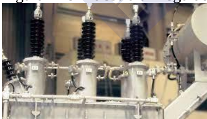
Figura 4-17 Regulador trifásico.
