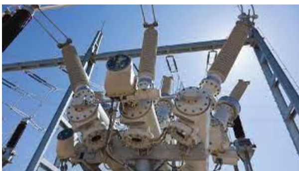
Figura 4-28 Interruptor de gas de 161 kV. Cortesía de Alliant Energy.
