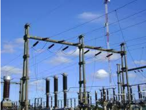
Figura 4-40 Ejemplo de bus típico.
