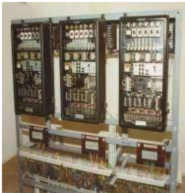
Figura 7-2 Relés Electromecánicos
