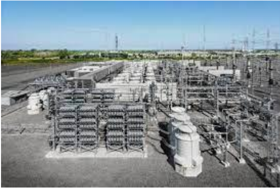
Figura 4-45 Compensador VAR estático.
