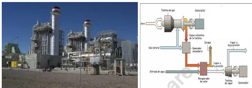
Figura 2-9 Planta de energía de turbina de combustión.
