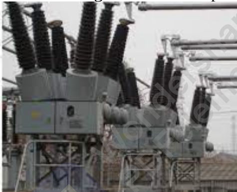
Figura 4-26 Interruptor de gas.
