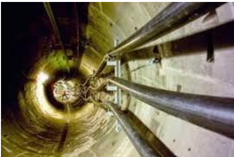
Figura 3-6 Transmisión subterránea.
