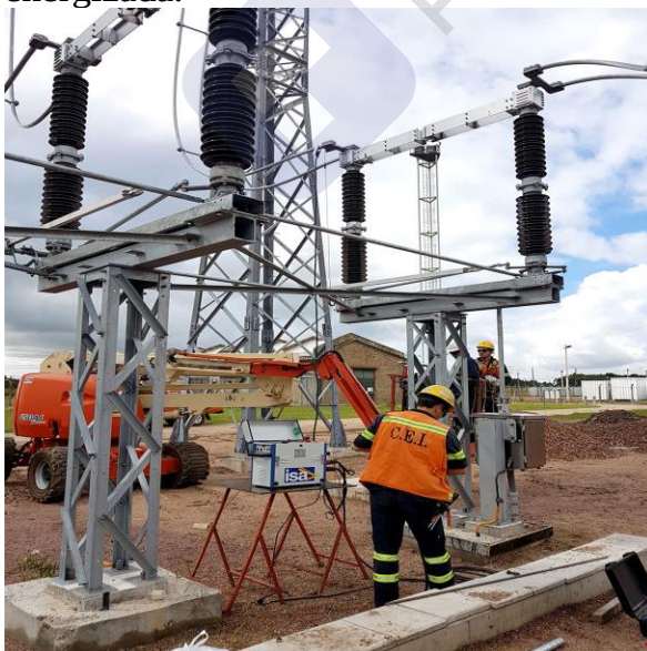
Figura 10-12 Mantenimiento de Subestaciones en vivo.
