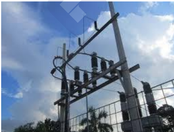
Figura 4-34 Seccionador vertical.
