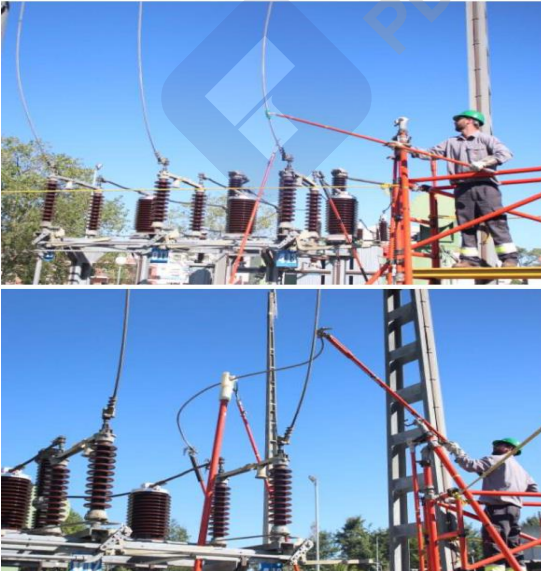
Figura 10-8. Mantenimiento de la línea viva
