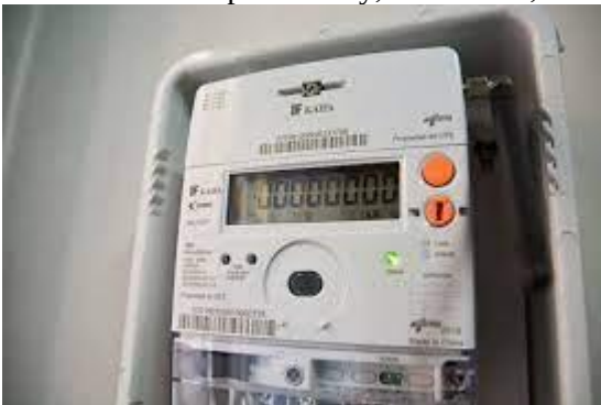
Figura 6-9 Contador inteligente residencial.
